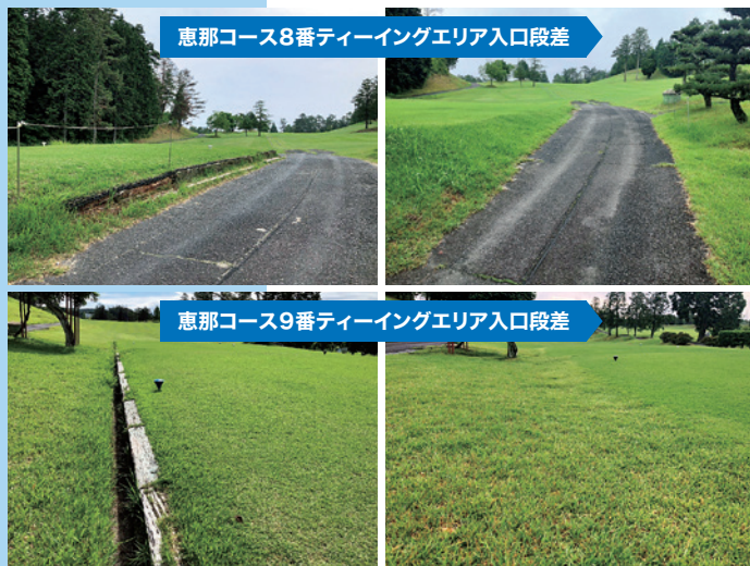
美岳CC恵那コースでは、8番ティーイングエリア入口の起伏を平坦に整備したほか(上)、9番ティーイングエリア入口の溝を埋める改修(下)を行うなど、バリアフリー対応を推進している
